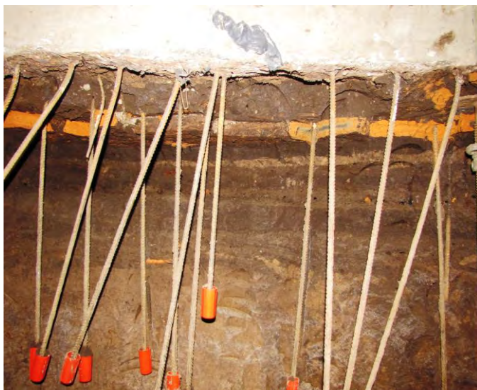
Figura 22. Piso de baldosas visto en el perfil de la excavación antes del hormigonado de la pared. Nótese los cinco niveles de estratigrafía que existen por debajo y otro por encima.
