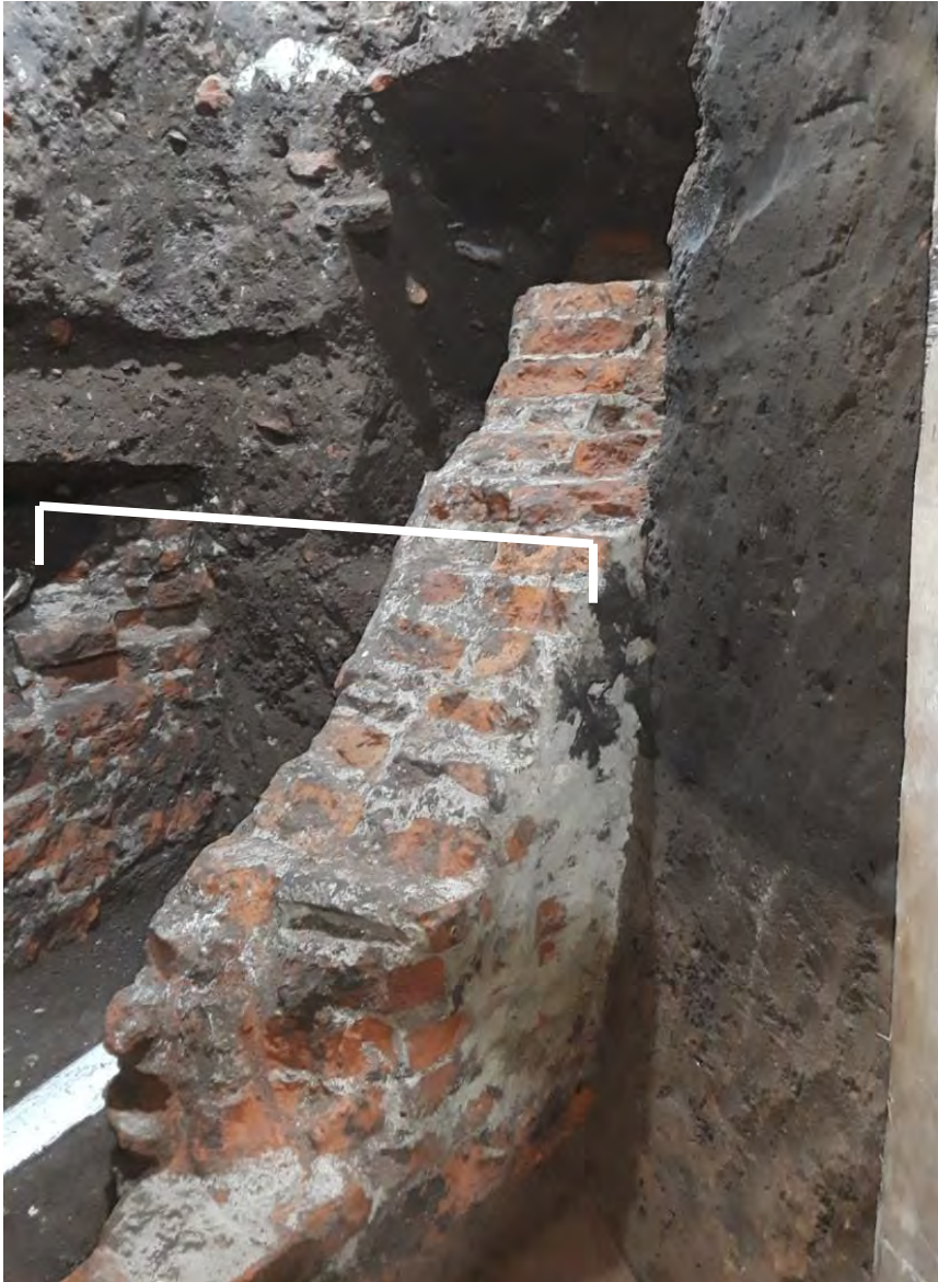
Figura 27. Estructura D: Muro de cimiento de idénticas características que la estructura A, se observa que conserva restos del revestimiento exterior a la cal. El caño que pasa por su interior lo dividió en dos mitades. La línea blanca indica el ancho total del muro.
