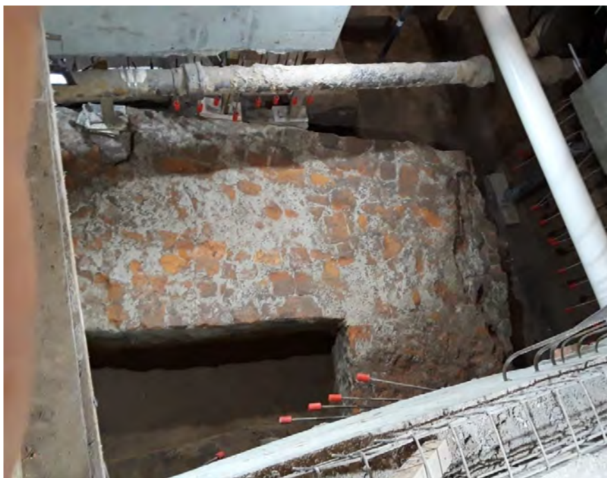
Figura 20. Basamento de muro en forma de L de 1,60 metros de ancho, hecho de fragmentos de ladrillos unidos con cal. Es posible que el muro superior haya sido destruido al pasar el caño de hierro que se ve encima, hacia 1884 o poco después.
