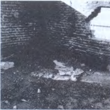
▲ Basura entre los muros históricos: nótese las marcas que el fuego dejó en el rincón, el carbón en el piso y la acumulación de casi un metro de sedimento.
