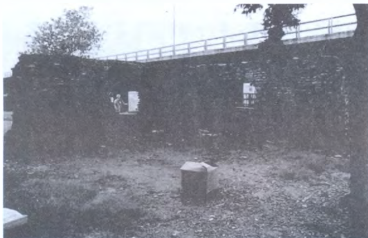
▲ Perspectiva del sitio al momento de iniciarse las excavaciones; nótese el estado general de abandono.
