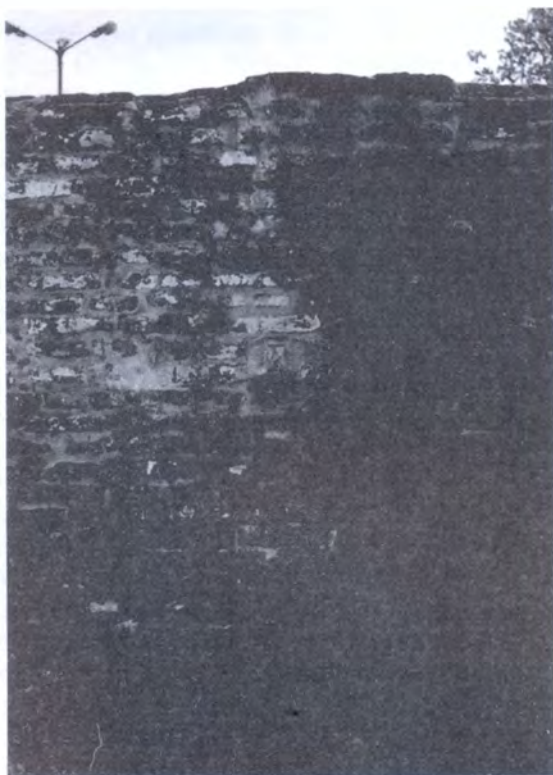
▲ Prueba de limpieza en el sector central de uno de los muros.
