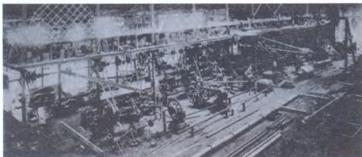
▲ El interior de uno de los talleres de fundición de Vasena. Se observa la acumulación de objetos y el vapor que impide la buena visión, pese al obvio arreglo para la foto.
