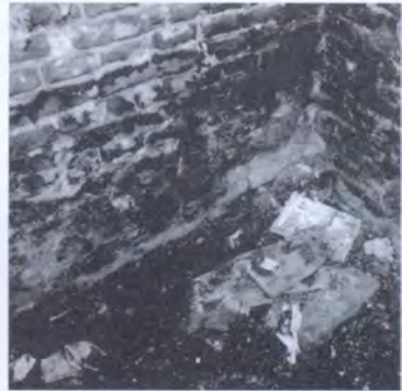
▲ Detalle de restos de carbón y hollín, ladrillos calcinados y restos varios de las actividades que, cada noche, afectaban el lugar histórico.
