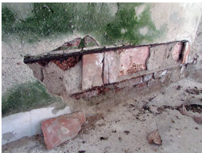
Figura 22. Baldosas de fabricación local sin marca, usadas como ajuste de espesores y relleno en revoques. Izq: Pabellón Osera del Zoológico (construido en 1894); Der: Barraca Peña.
