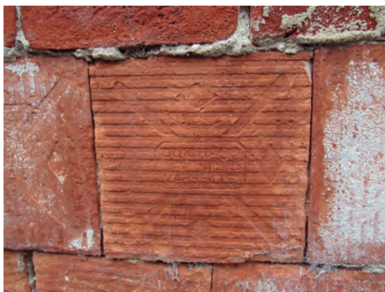
Figura 21. Baldosas de la fábrica Guichard Frères usadas para dar espesor al revoque (Capilla San Miguel de Paraná). Fotos: Marcelo Magadan.
