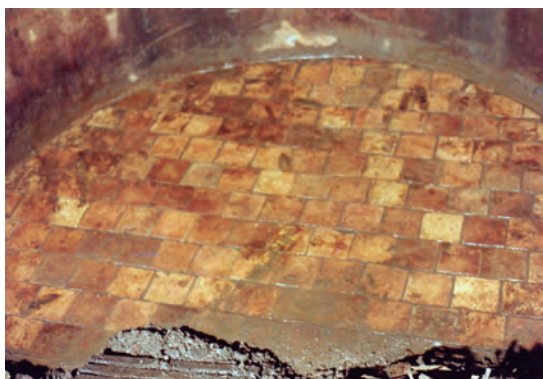
Figura 18. Vista del revestimiento de baldosas del Havre del fondo de la cisterna hallada en la Imprenta Coni (Perú 680).
