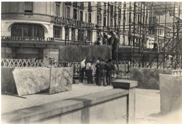
Montaje de los paneles de revestimiento. Exposición de Minería e Industrias afines 1944. (Colección Arq. Sabaté)
