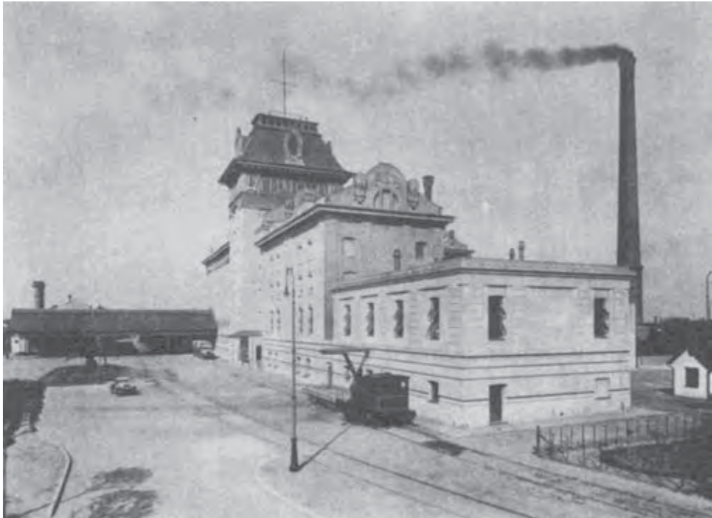
Fig 14. Bieckert 4 Edificio Principal Bieckert Llavallol c.1930. Con las ampliaciones de: Secadoras (al frente), Sala de Cocimiento, y ampliación naves botellería sobre desvío F.C. al fondo iz. Fuente: Historia de una cerveza centenaria , Centenario Bieckert. 1860-1960, Ed. de la Empresa, Buenos Aires, 1960.
