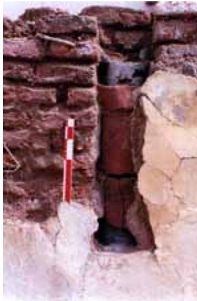
Sistema de descarga de agua de la terraza hacia el pozo del aljibe: el caño de hojalata recubierto con tejas.
