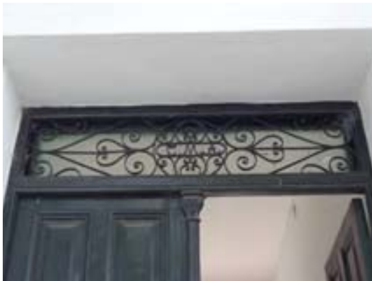
55. Detalle de la reja sobre el dintel de la puerta de la casa de Av. Del Libertador 16362, con las iniciales C. M. A., de Cecilia Muñoz de Alfaro. (Fotografía: Francisco Girelli, 2013).
