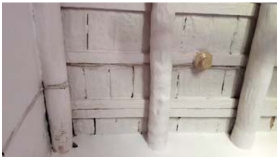
85. Detalle del techo del comedor de los Alfaro que coincide con la descripción documentada en la sucesión de Fernando Alfaro padre. Se observa un sensor contra incendios actual. (Fotografía de la autora).
