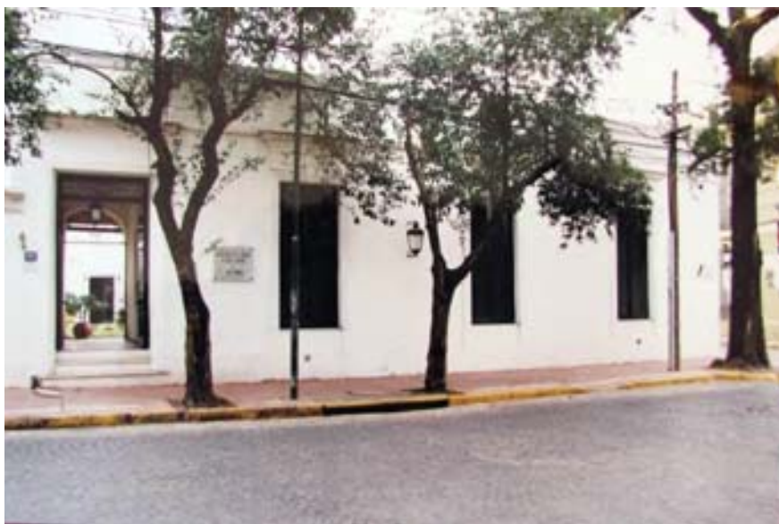
53. Frente sobre la Av. Del Libertador con la entrada principal a la vivienda. Fotografía tomada después de la inauguración del Museo, Biblioteca y Archivo Histórico de San Isidro en 1995. (MBAHSI).
