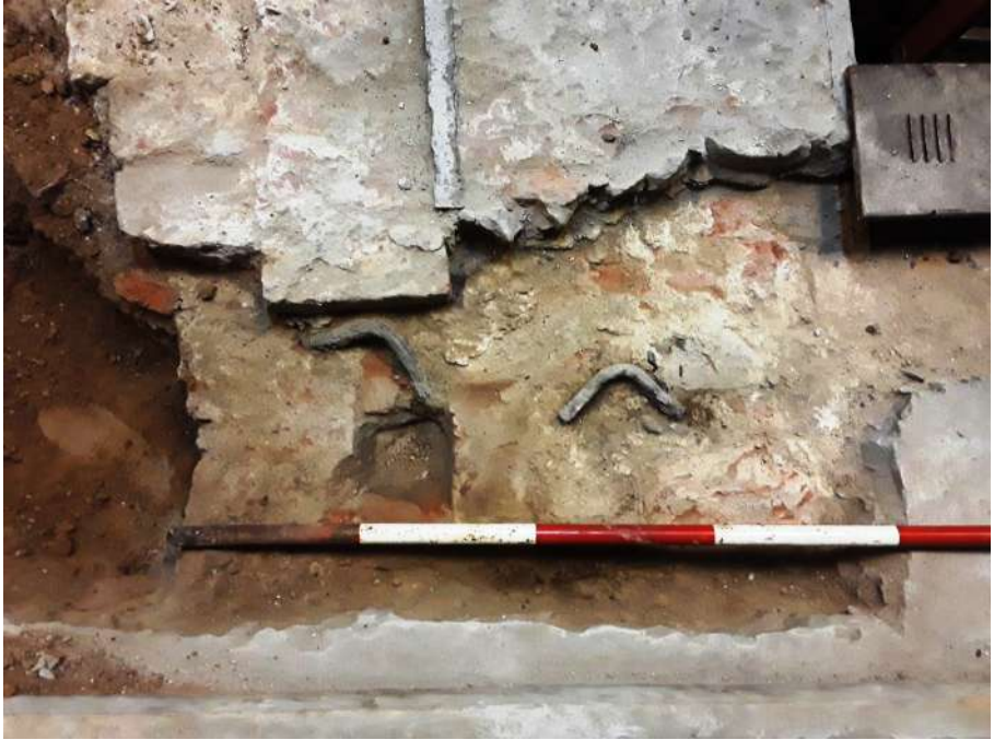
Soportes de la bomba para extraer agua que quedaron cubiertos por el piso posterior.
