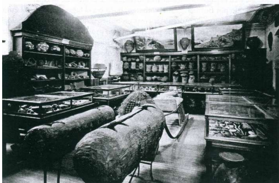
Salas con estanterías abiertas con objetos expuestos y vitrinas tipo mesa de muy fácil rotura, hacia 1906. Nótese el caño de iluminación a gas. (Fuente: Podgorny y Lopes 2008: 248)
