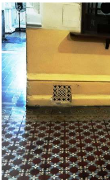
Ventilación del sótano tal como se ve actualmente, allí y en la planta baja.
