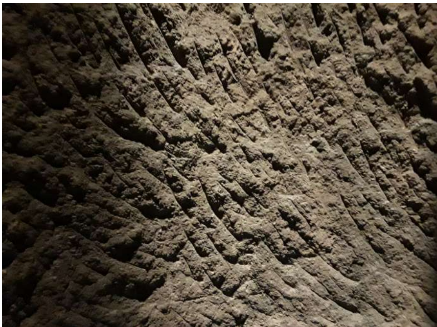
Marcas que dejó la forma de excavar el pozo circular mediante un pico.
