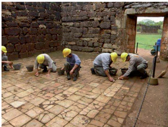
Figuras 14 y 15. Limpieza de pavimentos originales. Fuente: Documentación Obra Puesta en Valor 2009-2010.
