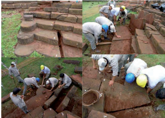
Figura 6. Recuperación de la escalinata característica de Santa Ana.
