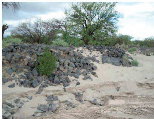
Figura 12. Ingenio Victoria. Barranca del río Santa María, en donde el socavamiento provoca la caída de escorias al lecho.
