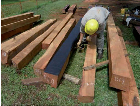
Figura 13. Preparativos previos a la colocación de los nuevos dinteles.
