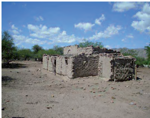
Figura 10. Ingenio Victoria. Construcción abandonada, probablemente la “casa de la administración”.
