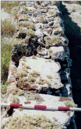
Figura 4. Vista superior del Muro 2. Nótese que en la porción inferior culmina con lajas dispuestas transversalmente mientras que en la superior se observa la disposición de muro doble con relleno de piedras pequeñas.
