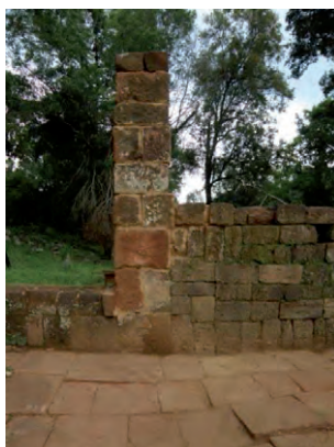
Figuras 2 a 5. Anastilosis y destape en el corredor externo del colegio de Santa Ana. Fuente: Documentación Obra Puesta en Valor 2009-2010.
