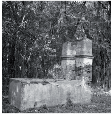
Figura 7. Pozo de balde
