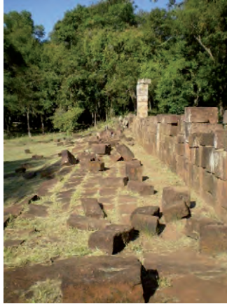
Figura 1. Vista de la galería externa del colegio de Santa Ana antes de la intervención. Fuente: Documentación Obra Puesta en Valor 2009-2010.
