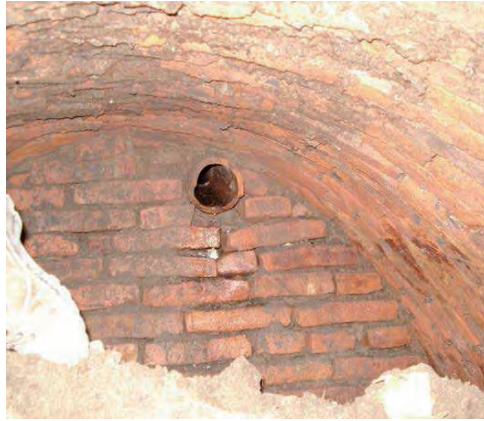
Figura 5. Extremo sur del túnel desemboca en predio lindero, con un caño de barro de desagote.
