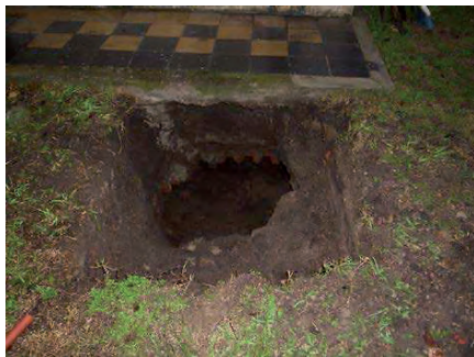
Figura 3. Excavación del techo del túnel.
