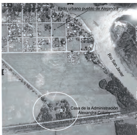
Figura 3: Vista aérea y ubicación de la CAAC en relación al río San Javier y al ejido urbano del pueblo de Alejandra.
