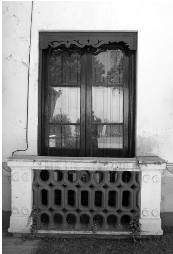
Figura 6. Ventana interna de la casa Alfaro.
