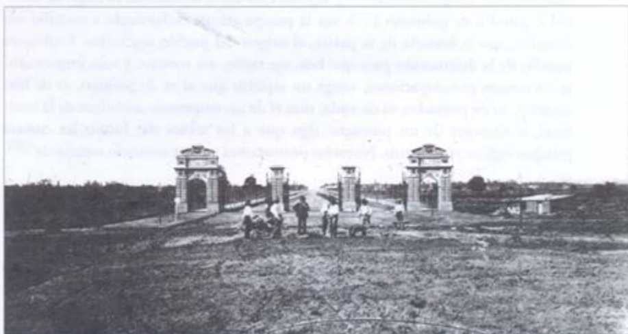
61. Los portones de entrada a Palermo durante la construcción, el gran proyecto de Sarmiento que se construía tardíamente sobre tierras que ya eran de hecho un parque.
