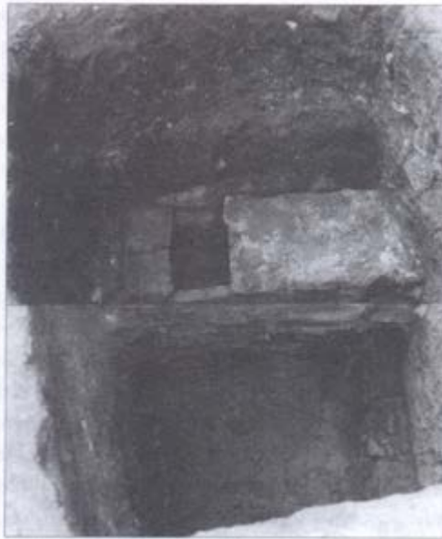
70. Albañal de desagüe encontrado en las excavaciones, ubicado en la parte frontal del edificio, correspondiente a la época del Colegio Militar.
