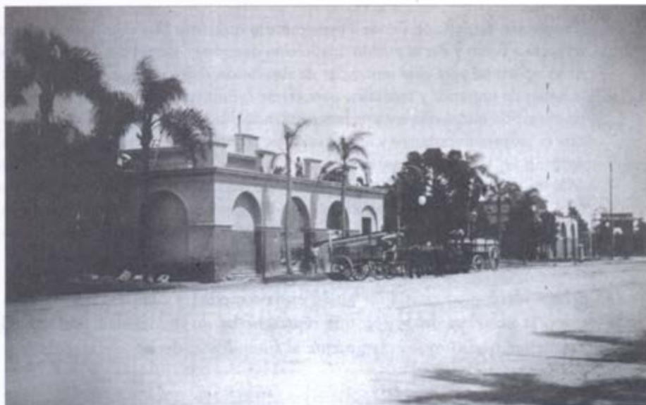
57. Inicio de las obras de demolición: los carros se llevan las rejas de las azoteas y demuelen los pilares para sacarlas
