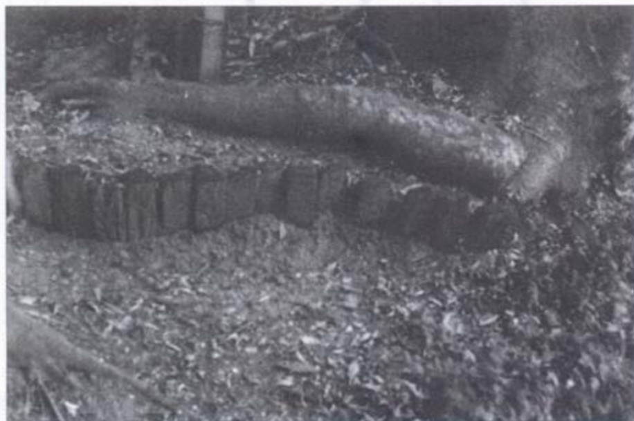
90. El tablestacado de madera que limitaba el zanjón de Rosas, ahora parcialmente enterrado pero aun a la vista.
