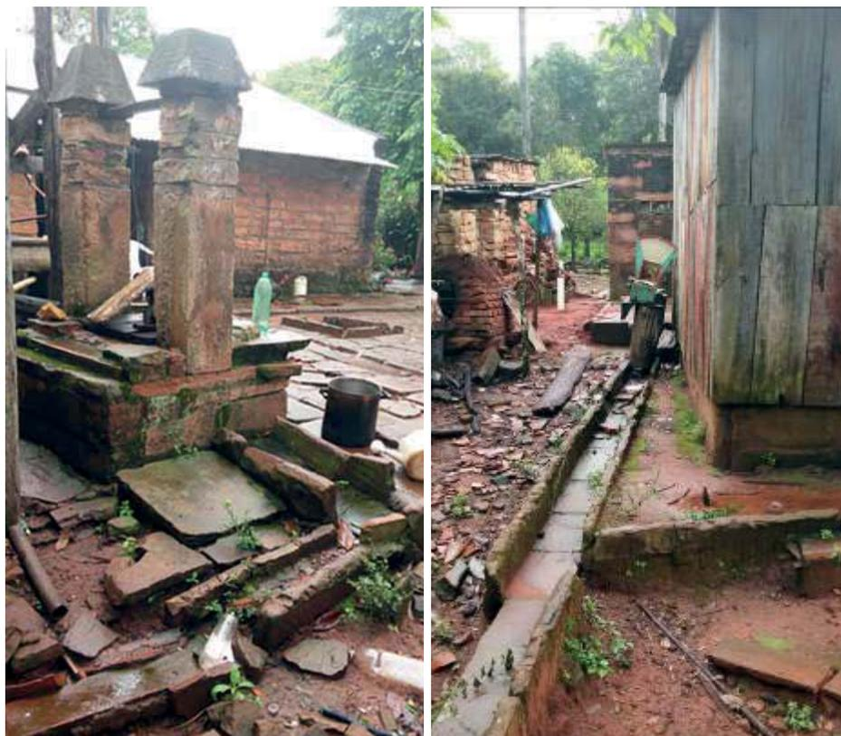
**Figura 10.** Sistema de distribución de agua en una casa actual, desde un aljibe mediante canales, totalmente hecho en piedra.
