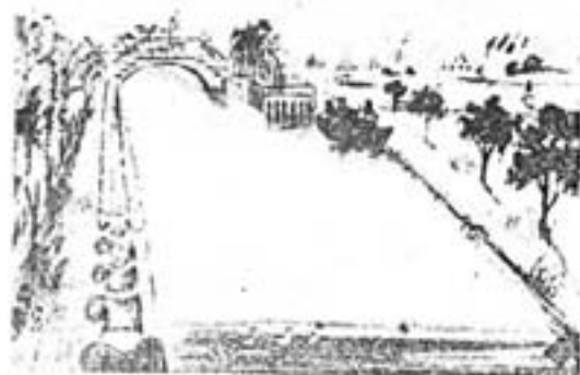
CANAL ANEXO A LA RESIDENCIA. Dentro del terreno del caserón.
