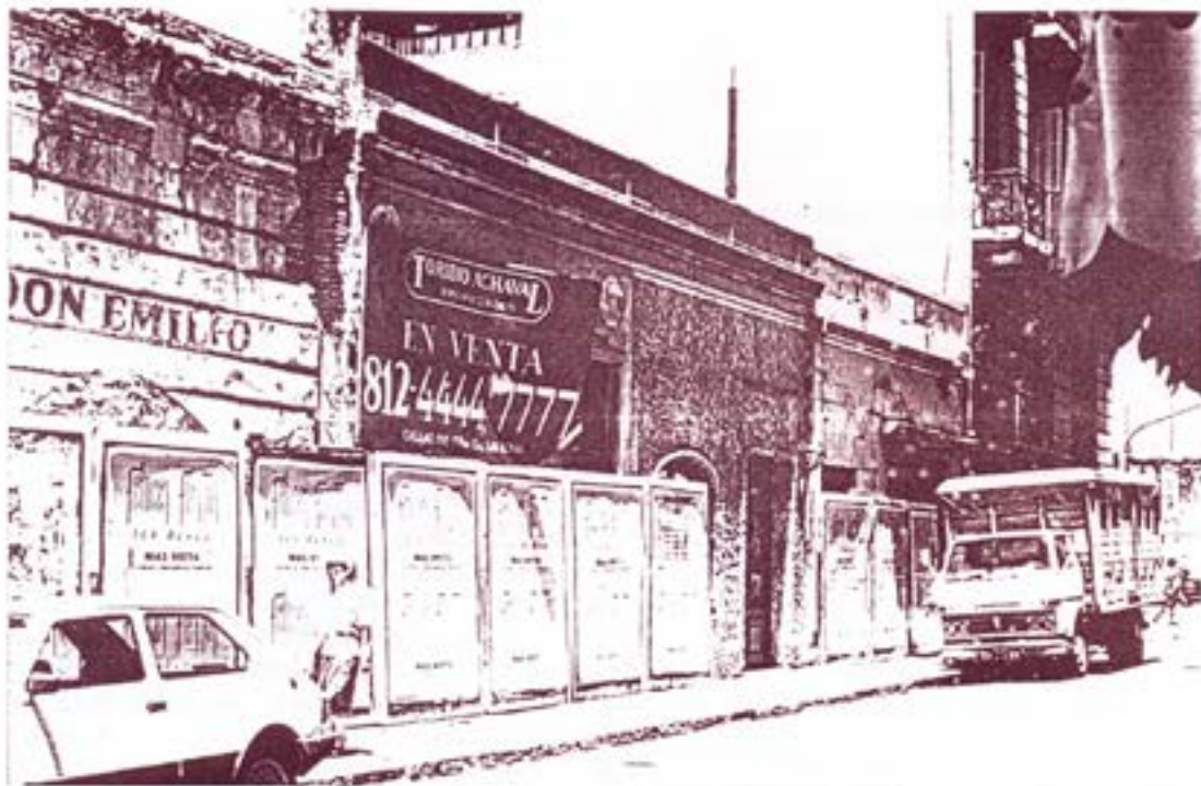
Vista de la calle Defensa entre San Lorenzo e Independencia, con las fachadas de los dos conventillos simétricos; a la izquierda la Casa I, a la derecha el único edificio posterior.
