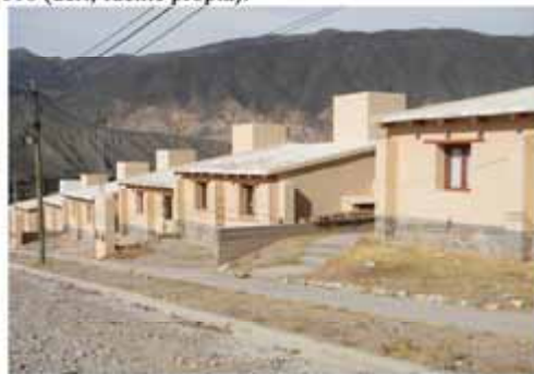
Figura 4: Conjunto de 50 viviendas del PFCV en Sumay Pacha Sur. Fuente propia (2011).
