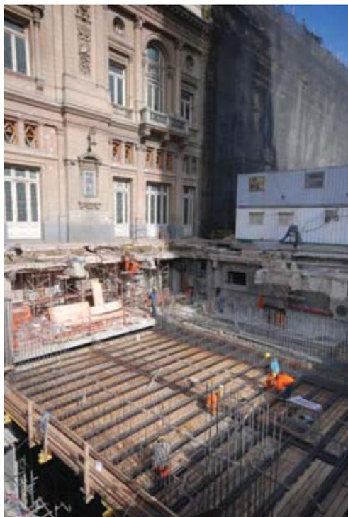
ARMADO DE LOSA SOBRE EL TERCER SUBSUELO.
