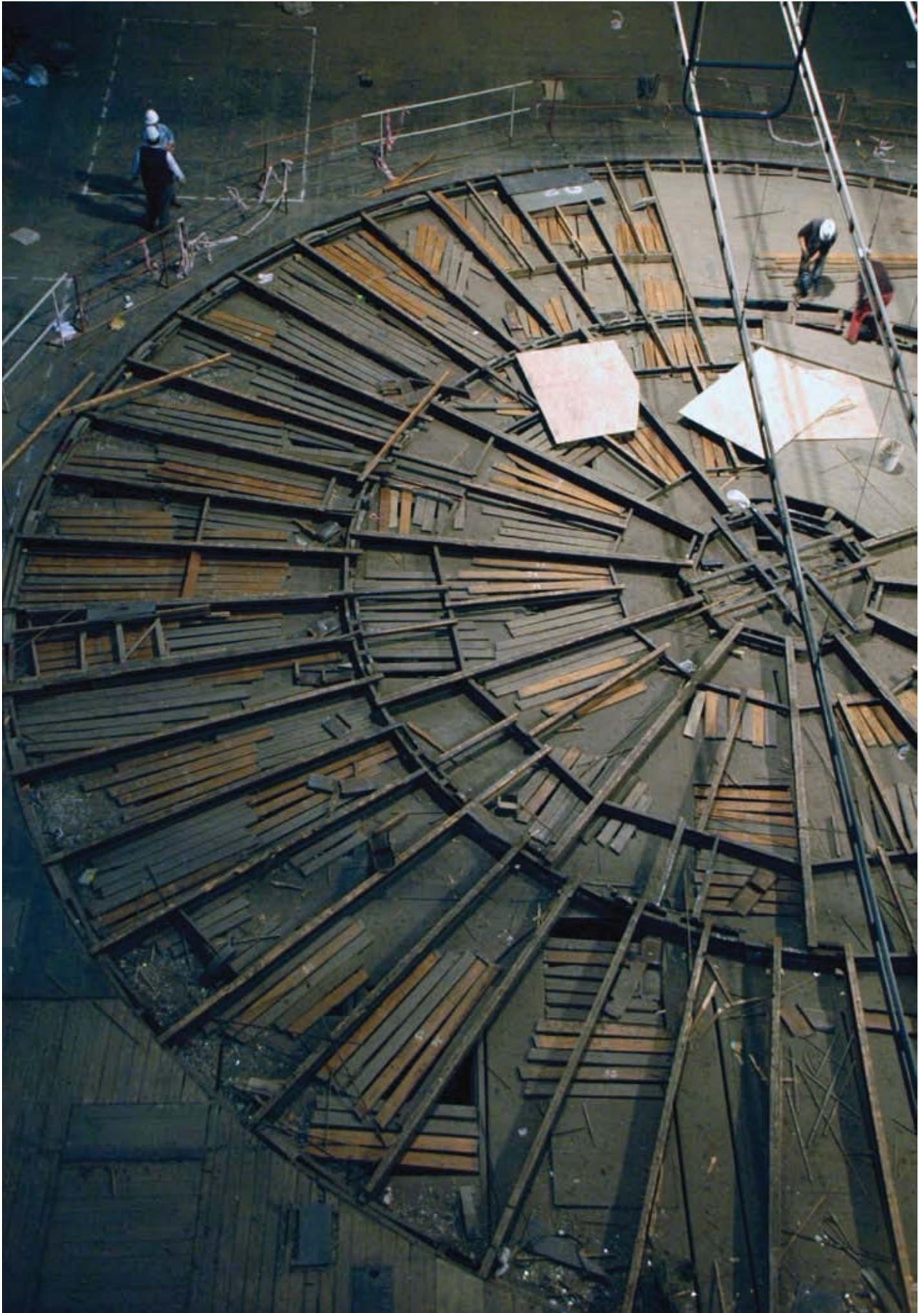
LEVANTAMIENTO DEL PISO DE MADERA EXISTENTE DEL DISCO GIRATORIO EN EL ESCENARIO.
