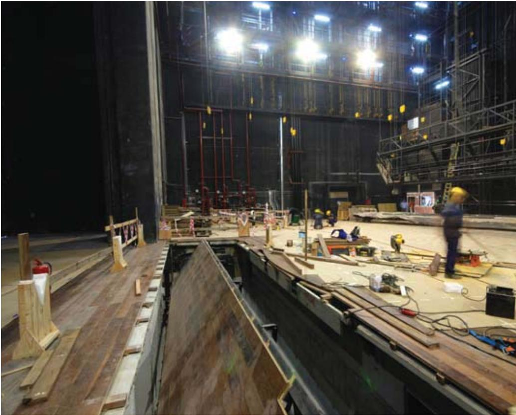
ESCENARIO: TAPA MECANIZADA. PLATAFORMA DEL MONTACARGAS N° 3.
