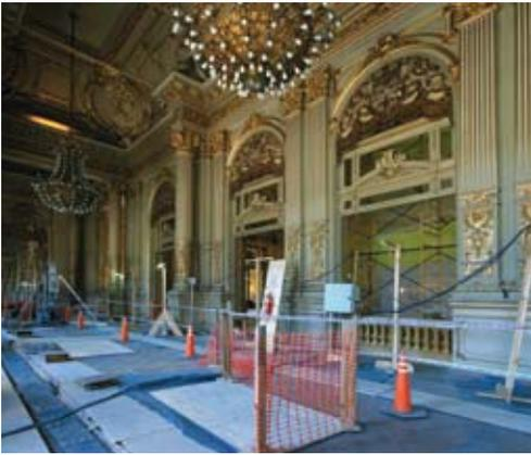
PISODUCTO PARA LA INSTALACIÓN ELÉCTRICA BAJO GUARDAS DEL PISO DE ROBLE DE ESLAVONIA DEL SALÓN DORADO.
