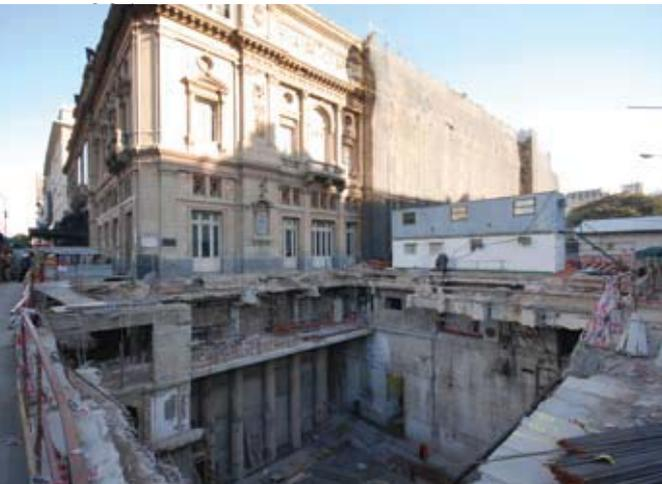
TRABAJOS DE SUBMURACIÓN MEDIANTE PILOTES
