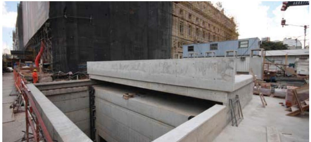
TRABAJOS DE SUBMURACIÓN MEDIANTE PILOTES Y UN MURO PANTALLA.
