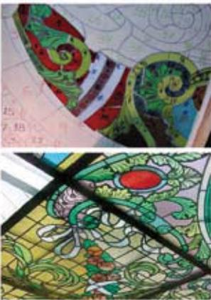
utilizaron óxidos de cobre, cobalto, cromo, zinc y bicarbonato de potasio. Los rangos de cocción y vitrificación de los vidrios oscilaron entre los 800 °C y 750 °C.
