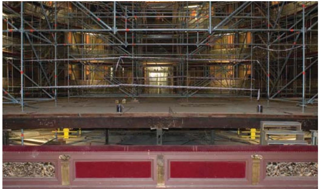
ESTRUCTURA AUTOPORTANTE DE ANDAMIOS EN LA SALA SOBRE EL PISO DE PLATEA NIVELADO HORIZONTALMENTE.
