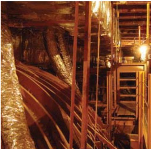
CONDUCTOS DE INYECCIÓN Y RETORNO DE AIRE EN EL ENTRETecho DEL SALÓN DORADO.
