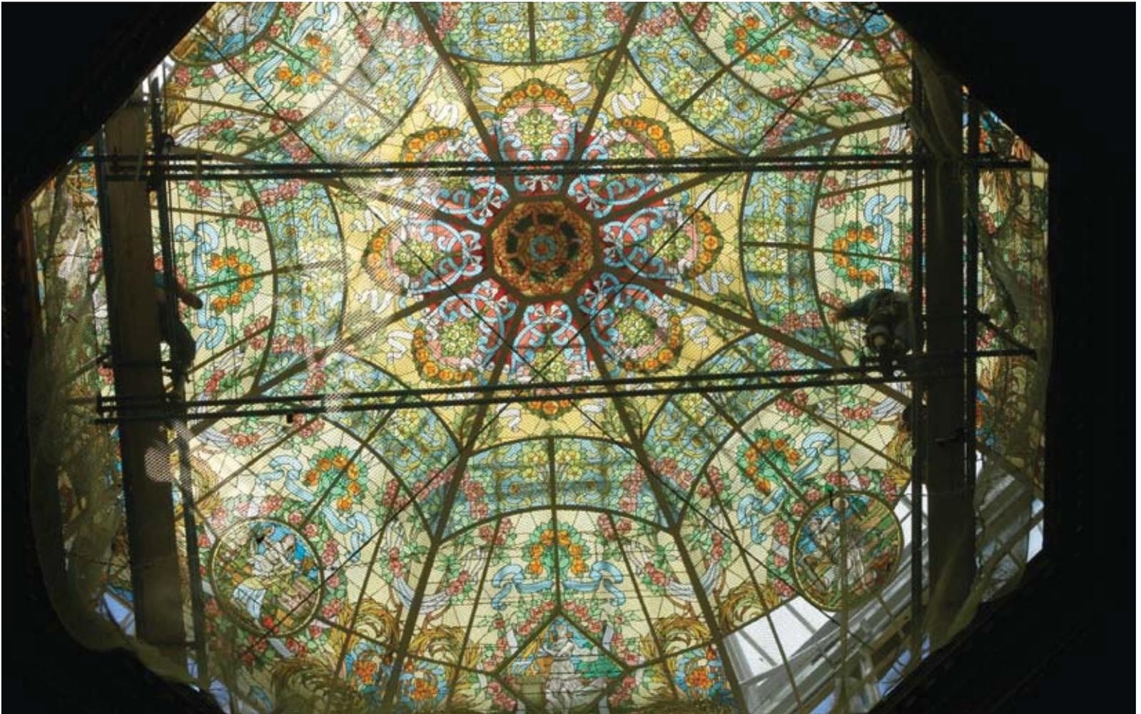
VITRALES DE LA CÚPULA CENTRAL CON ESTRUCTURA DE PROTECCIÓN DURANTE LA OBRA.
