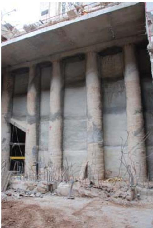
MURO PANTALLA Y PILOTES DURANTE LOS TRABAJOS DE DEMOLICIÓN Y EXCAVACIÓN.
